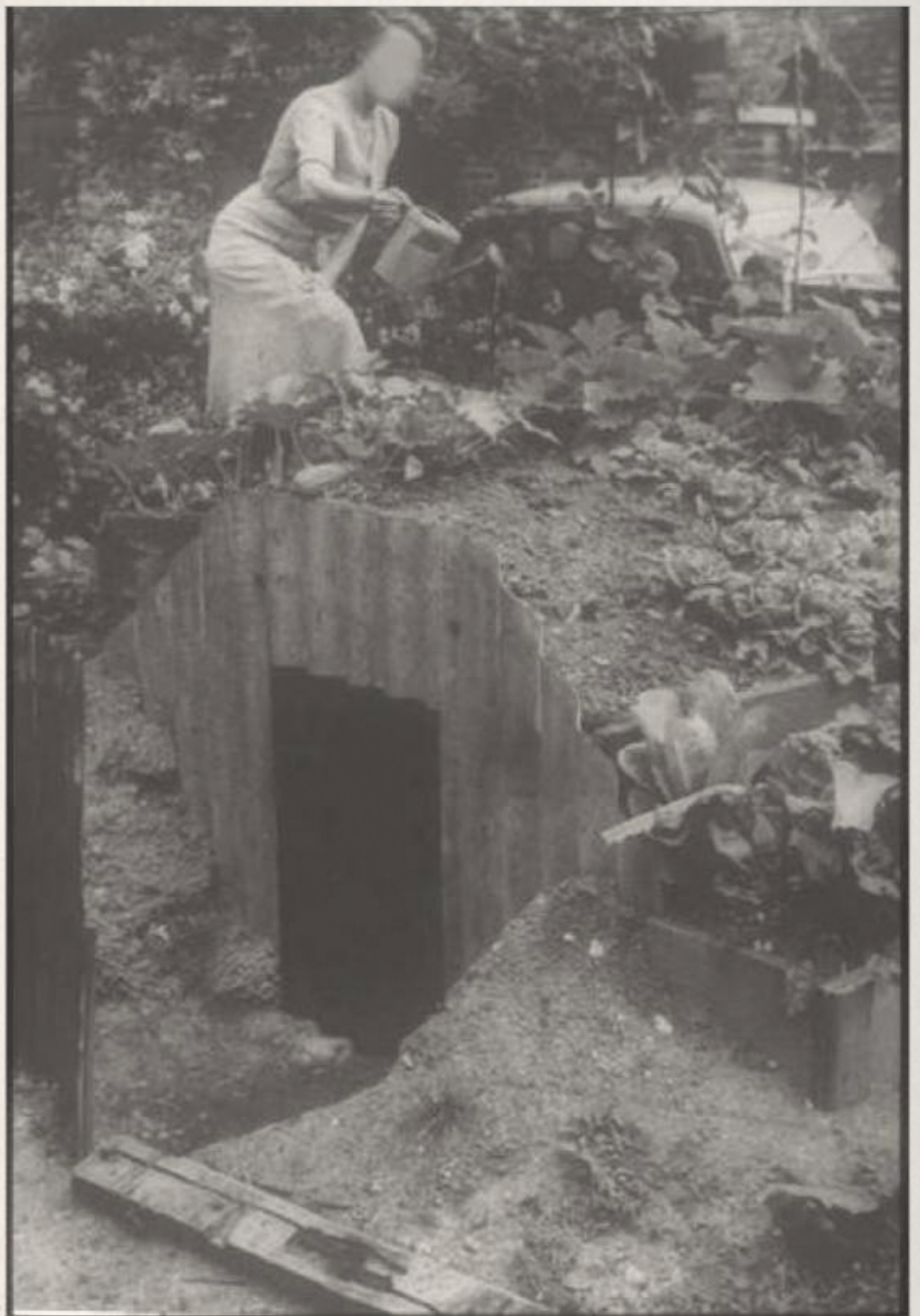
Construção de um abrigo Anderson algures no Reino Unido
