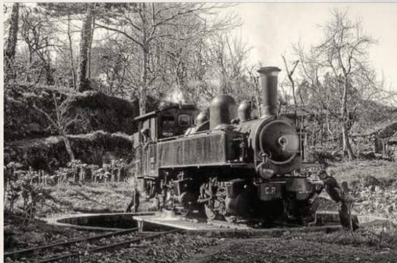
Locomotiva CP E163 a mudar de direção na Estação de Arco de Baúlhe a 2 de Março de 1982
