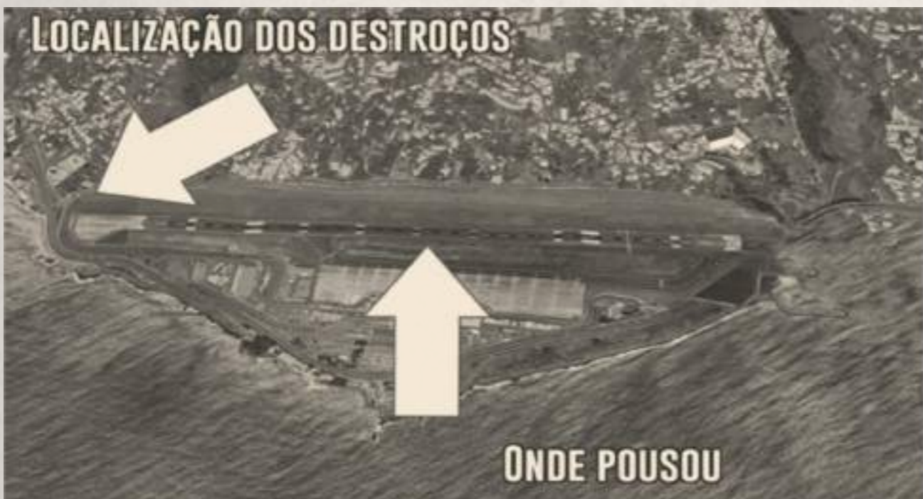
Perspectiva aérea, com as posições dos eventos chave que culminaram no acidente.
